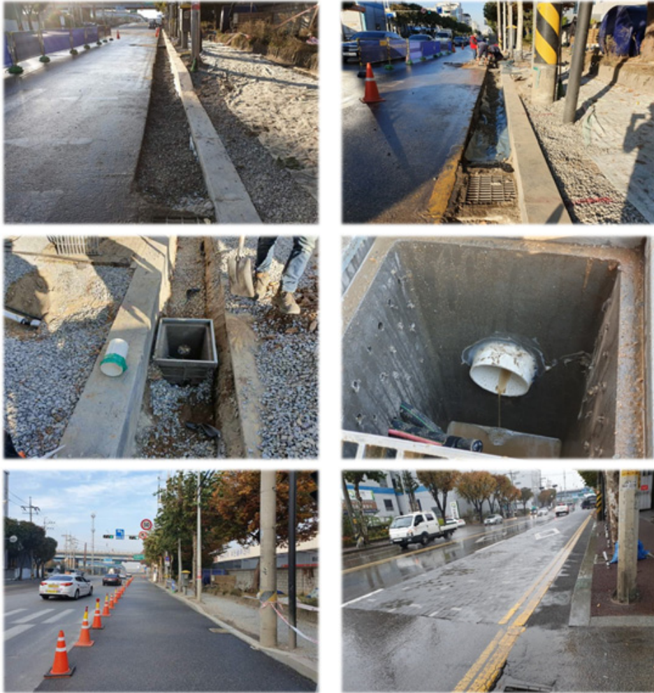
[그림 5-9] 도로 테스트베드의 공사 과정
