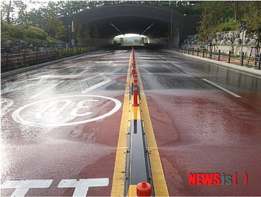
[그림 2-18] 빗물을 이용한 노면 살수 및 용설 시스템 (뉴시스, 2013.11.07)
